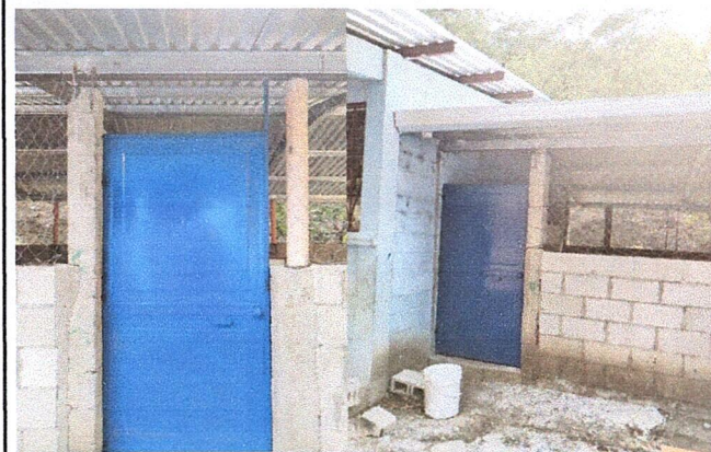
Foto 3: Mejoramiento e instalación de puertas de metal, finalizado.
